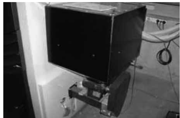
Einschub- und Behältermontage am Kessel
